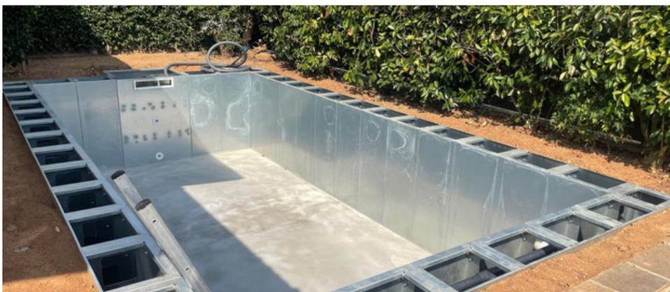
3. Viene collegata tutta l'impiantistica e si procede con la posa del telo interno in PVC. Tutte le operazioni avvengono all'interno della piscina, senza pericolo di intaccare ciò che c'è all'esterno.
